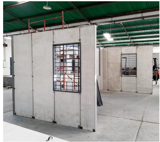
Inicio de instalación de vivienda probeta en la planta de iCreativa Panel C.A.
