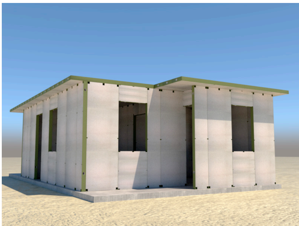
Aspecto general del acabado de la vivienda, una vez terminado la colocación de todos los paneles sin incluir ningún acabado.
